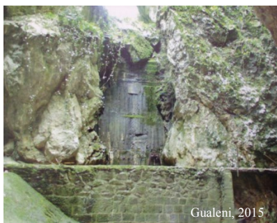
Figura 10 Il muro in cemento armato di sbarramento della forra
