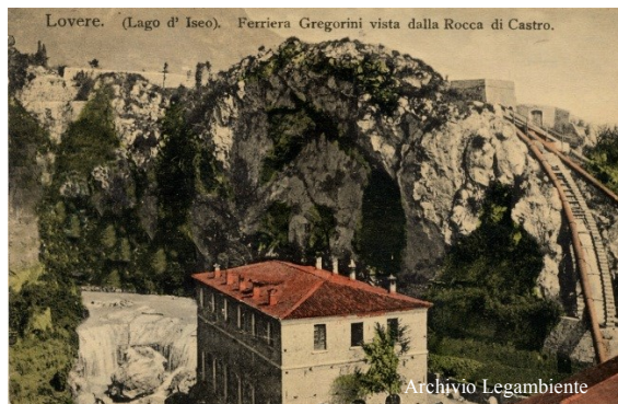
Figura 7 Il torrente Tinazzo esce dalla forra con una spettacolare cascata che lambisce la centralina idroelettrica della fabbrica Gregorini (1900)
