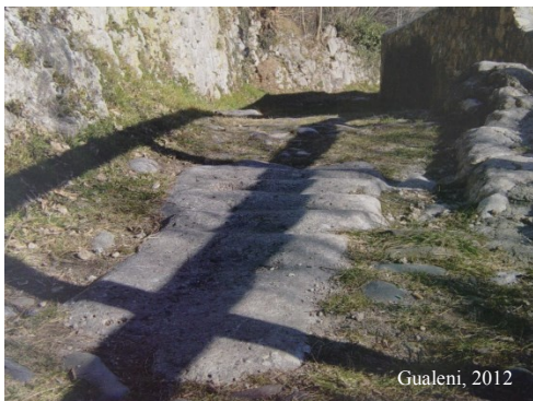
Figura 4 Tracce dell'acciottolato che permetteva il passaggio dei carri
